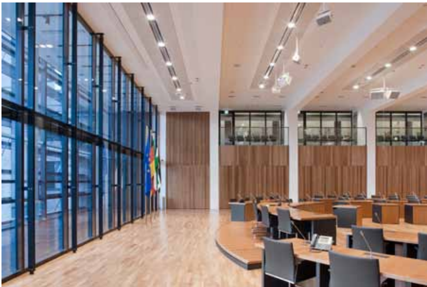
Multifunktionale Lichtkanäle mit integrierten Rasterleuchten, HIT- und Halogen-Niedervolt-Downlights für nutzungsabhängige Beleuchtung
